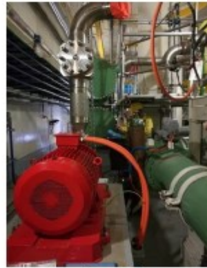
TŘETÍ SYSTÉM CHLAZENÍ BAZÉNU SKLADOVÁNÍ
