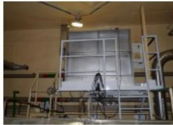
TŘETÍ SYSTÉM CHLAZENÍ BAZÉNU SKLADOVÁNÍ
